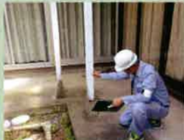
建物外部の異常箇所をチェック
