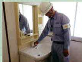
通水による水道管の腐食防止 排水管の封水(臭気防止)
